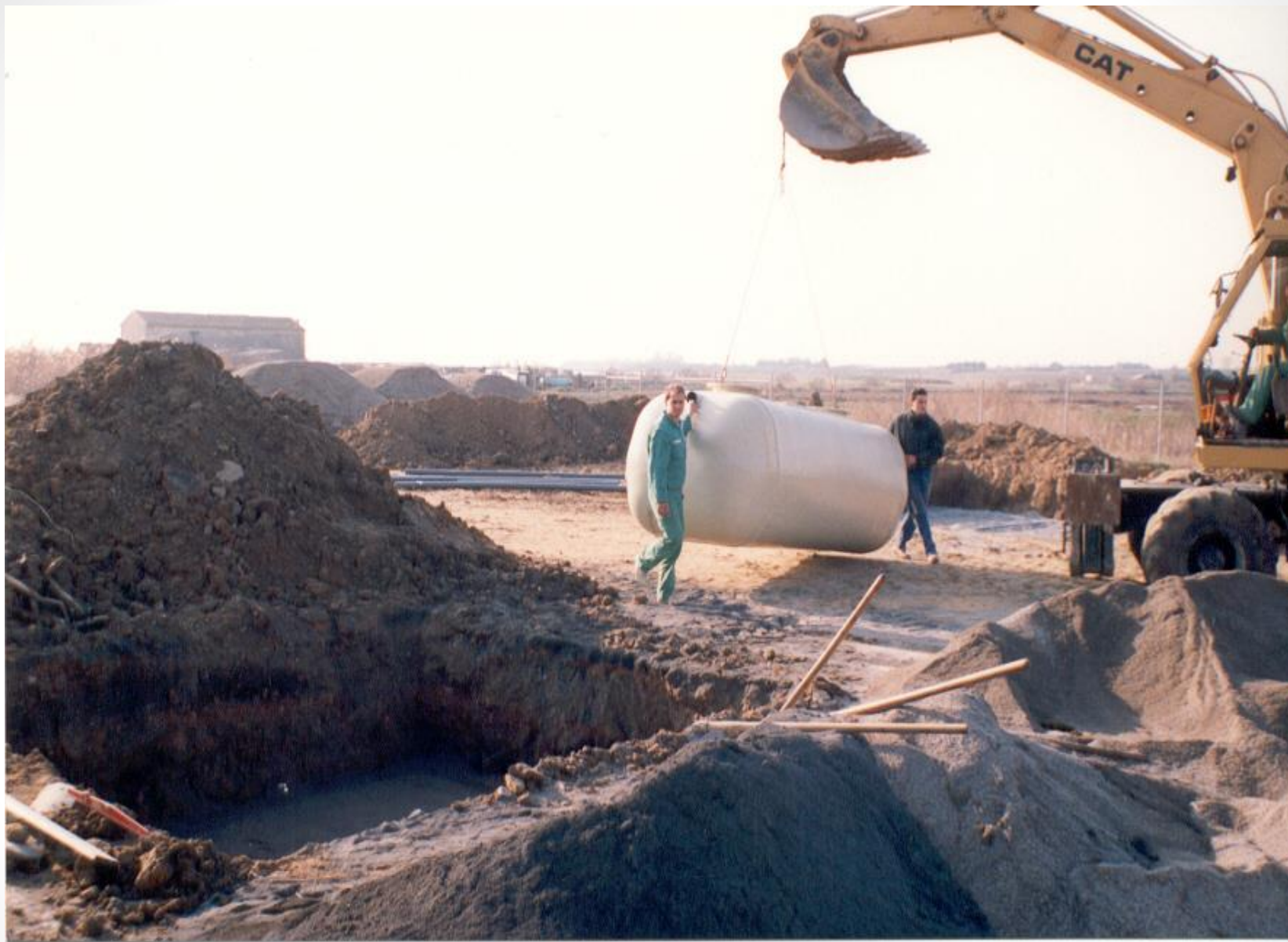
Tanque Séptico – aspectos constructivos
