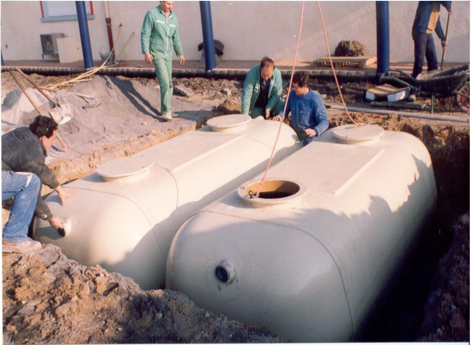
Tanque Séptico – aspectos constructivos
