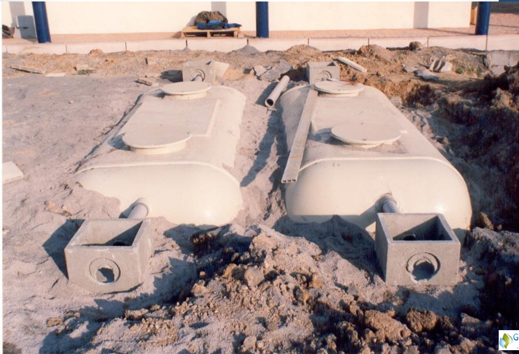
Tanque Séptico – aspectos constructivos
