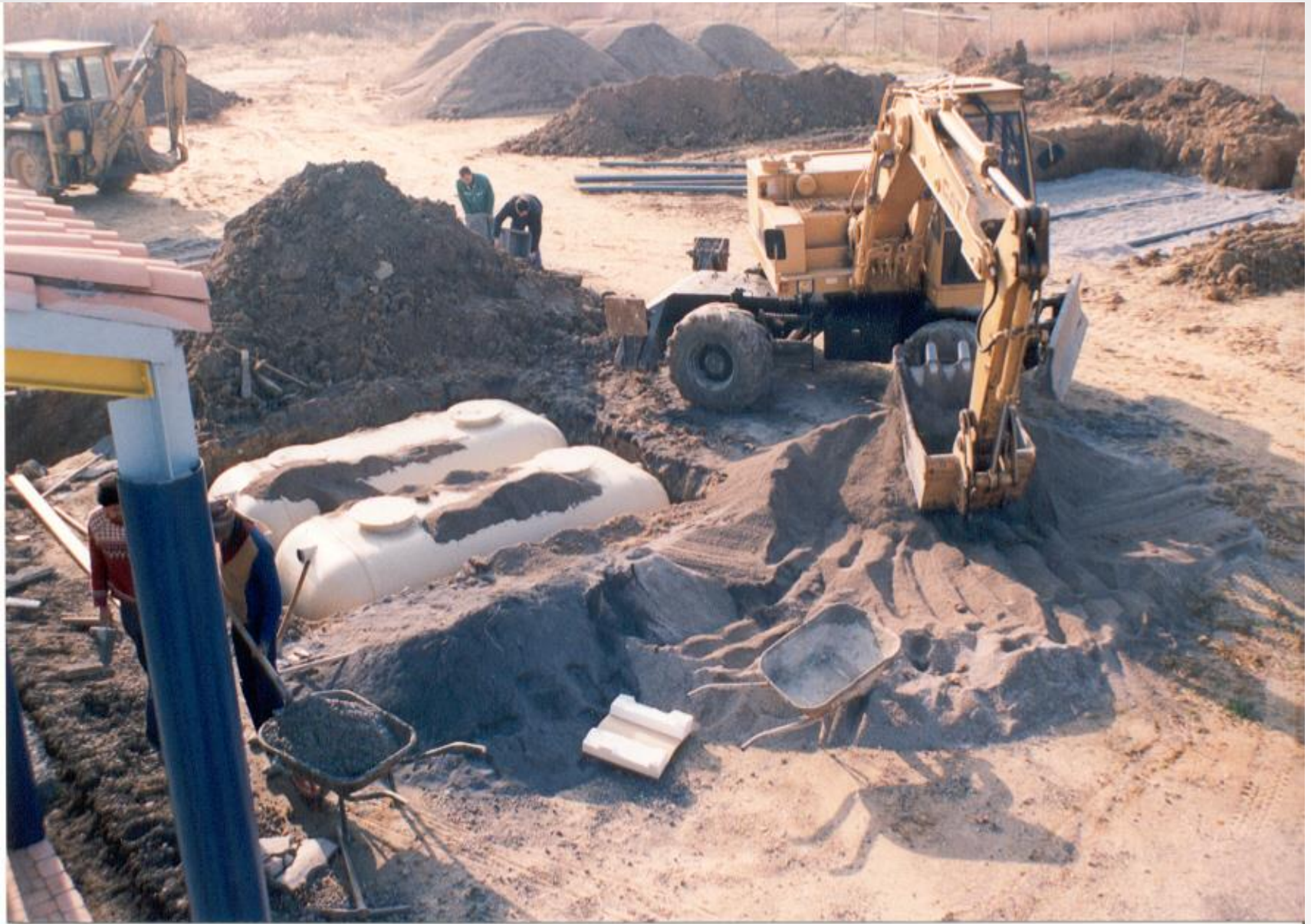
Tanque Séptico – aspectos construtivos
